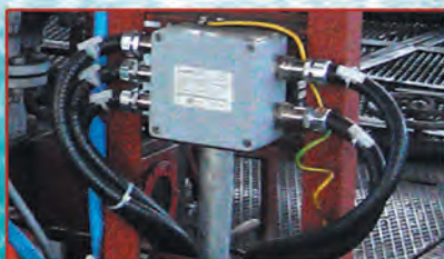
Взрывозащищенная соединительная коробка ГЕРДА-КСА с установленными взрывозащищенными кабельными вводами типа КМ (с внутренней резьбой). В вводы КМ вкручены соединители ГЕРДА-СГ с герметичным металлорукавом ГЕРДА-МГ
